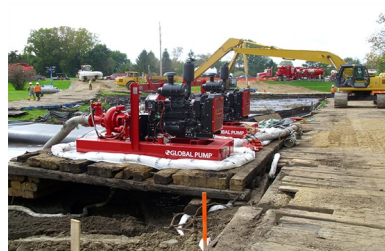
Travaux environnementaux, fracturation hydraulique, alimentation en eau
